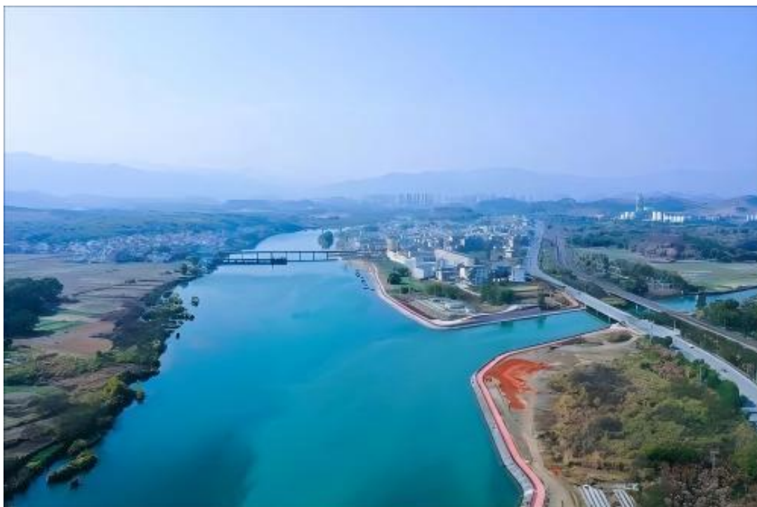
（北江航道扩能升级上延工程）
